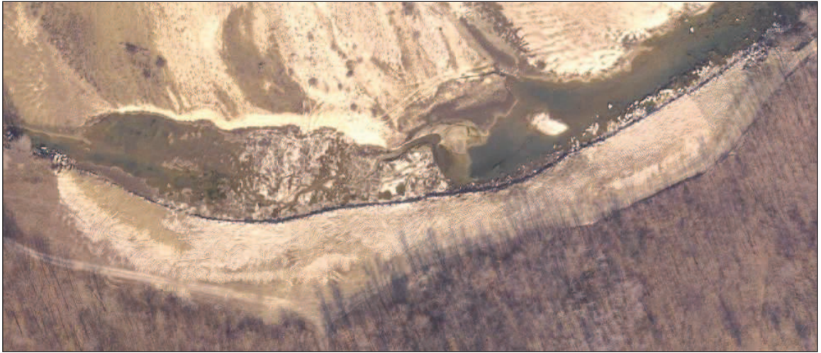
Figura 7.7 – Difesa spondale danneggiata.
